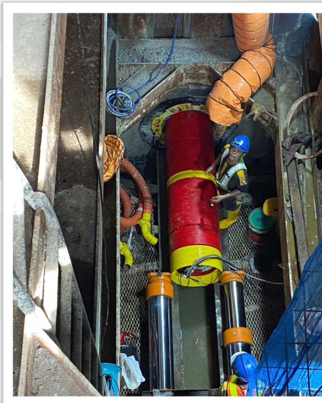
Adhi - Hutama KSO Pekerjaan Konstruksi Jaringan Pipa Air Limbah Jakarta Sewerage Zone 1 Paket 6
